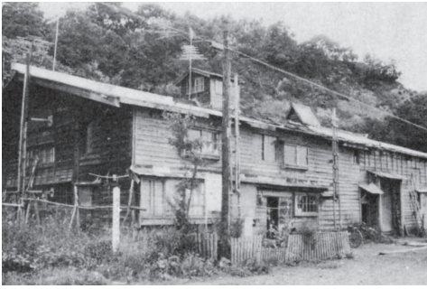
▲修理工事前の運上家（昭和40年代）
