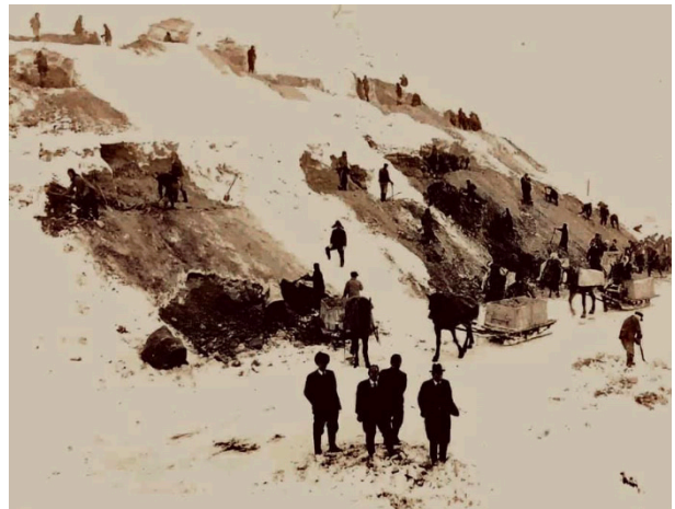
▲写真 切り通しの工事が（時期不明）
