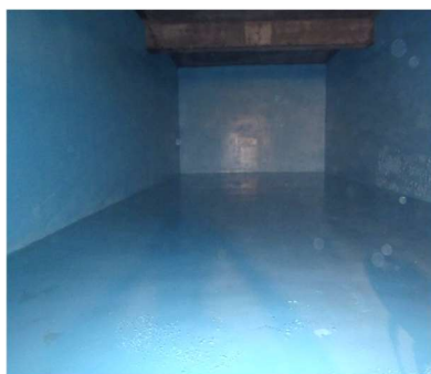
図 10. 栄地区配水池内部
