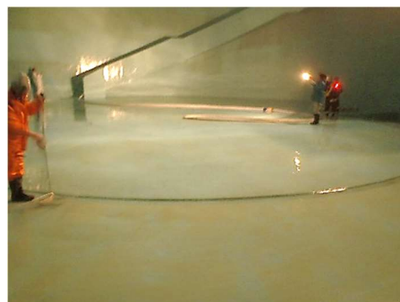
図 11. 朝日2号配水池清掃状況
