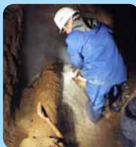
老朽し破裂した水道管の深夜の復旧作業
