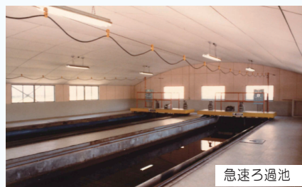
急速ろ過池上屋
