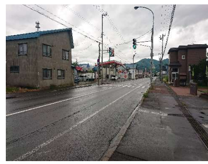
⑥国道5号線 黒川小学校前
