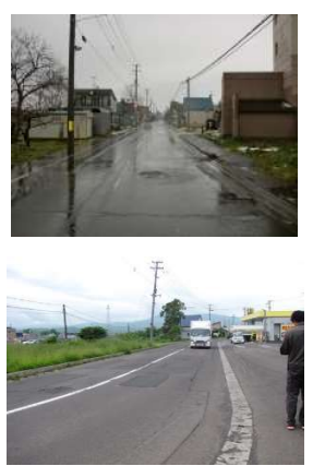
①町道 旧国道5号線
