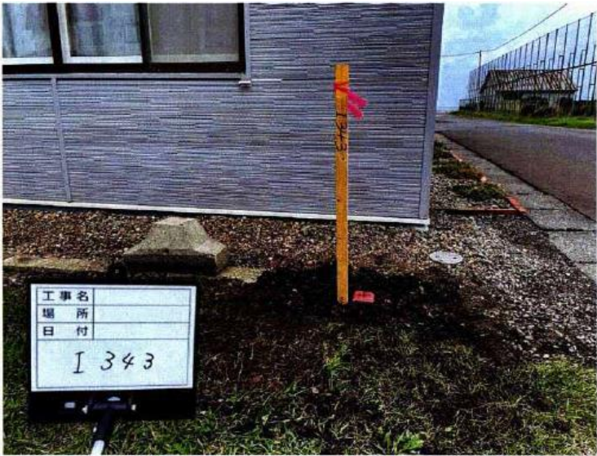
No. 余市郡余市町大川町15丁目 境界標設置 (TS) I343 新設コンクリート標 令和3年10月4日 撮影 近 景
