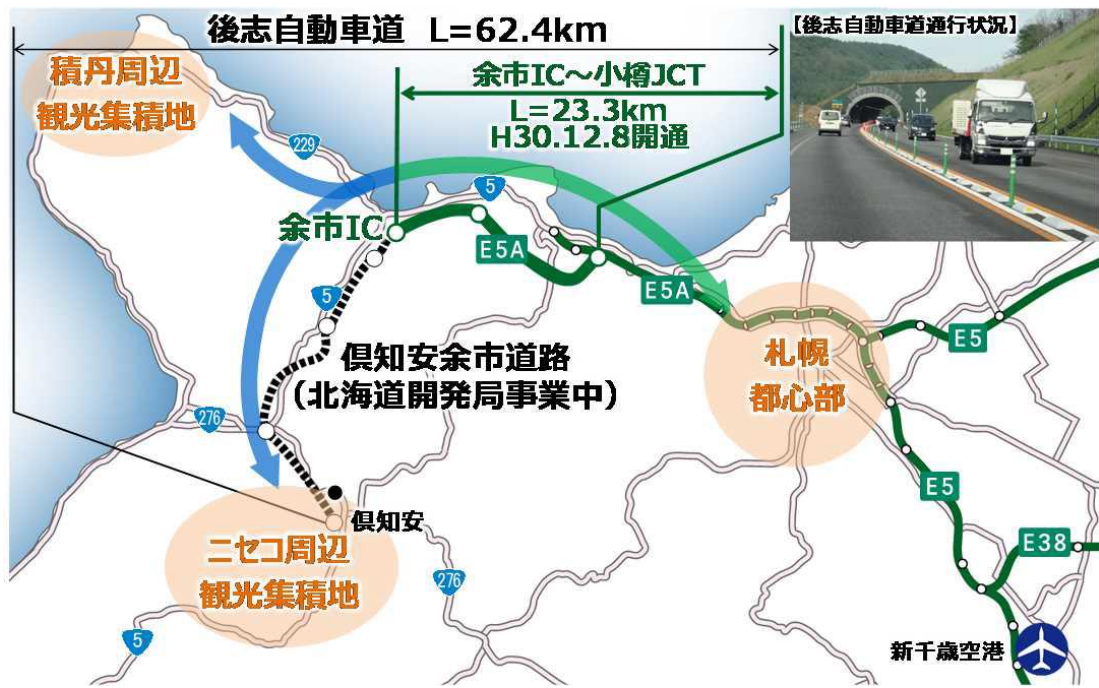
図3.10 後志自動車道開通状況
