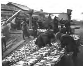
生鯧箱詰め作業 奥寺家
